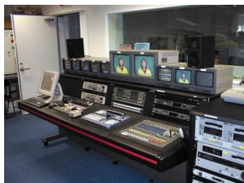
ケーブルテレビ (CATV) システム
